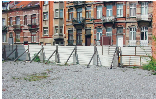
Bouwtrein parking Zonnelied
